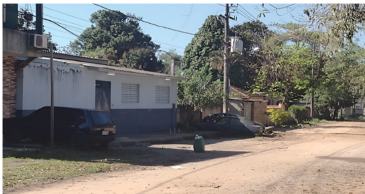
Fachada da escola-abrigo.
