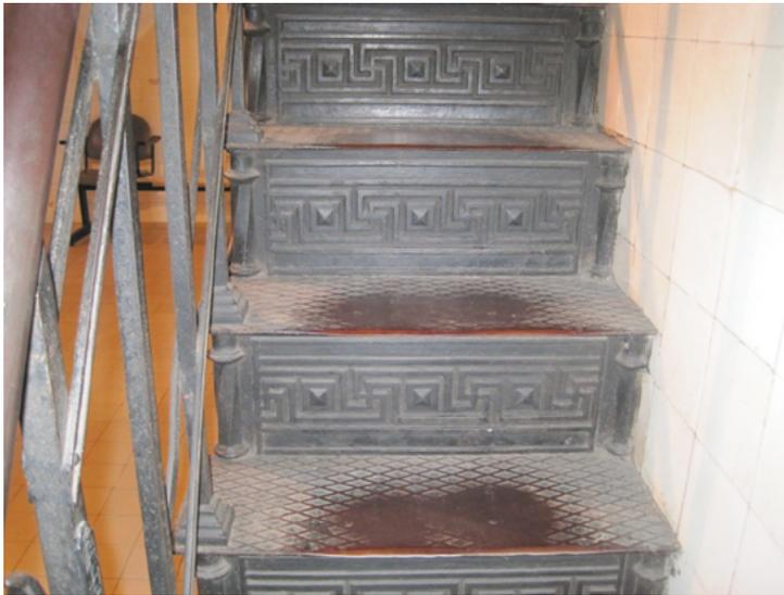
**Figura 4.** Desgaste em escada metálica causado pelo fluxo contínuo de pessoas.
