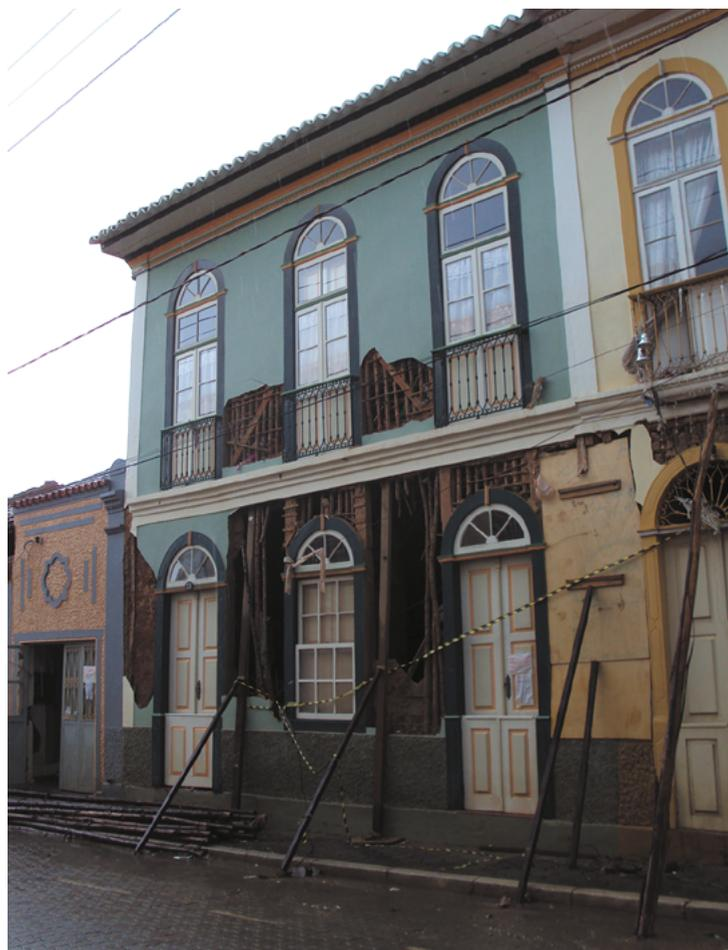
**Figura 7.** Deterioração de fachada em adobe causada pela inundação em São Luiz do Paraitinga.
