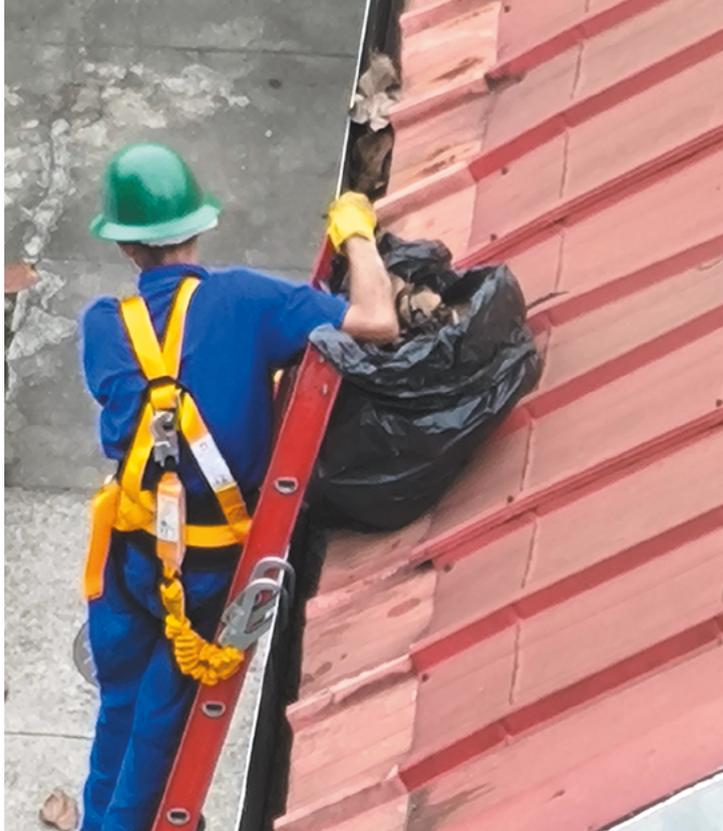
**Figura 37.** Realização de serviço de inspeção e limpeza na cobertura.
