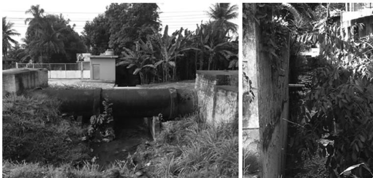
**Figura 19.** Adutora do Guandu, paralela à BR-465, sobre córrego poluído; e lançamento de esgoto doméstico in natura, em Seropédica.
