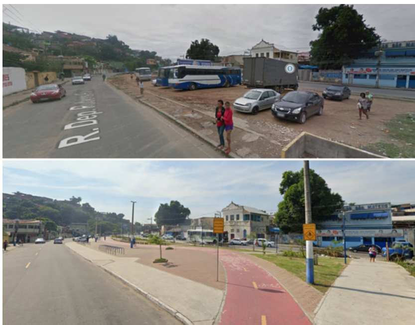
Figura 11. Antes (2017) e depois (2019) da implantação de ciclovia e urbanização na Rua Dep. Rubens Paiva em São João de Meriti.
